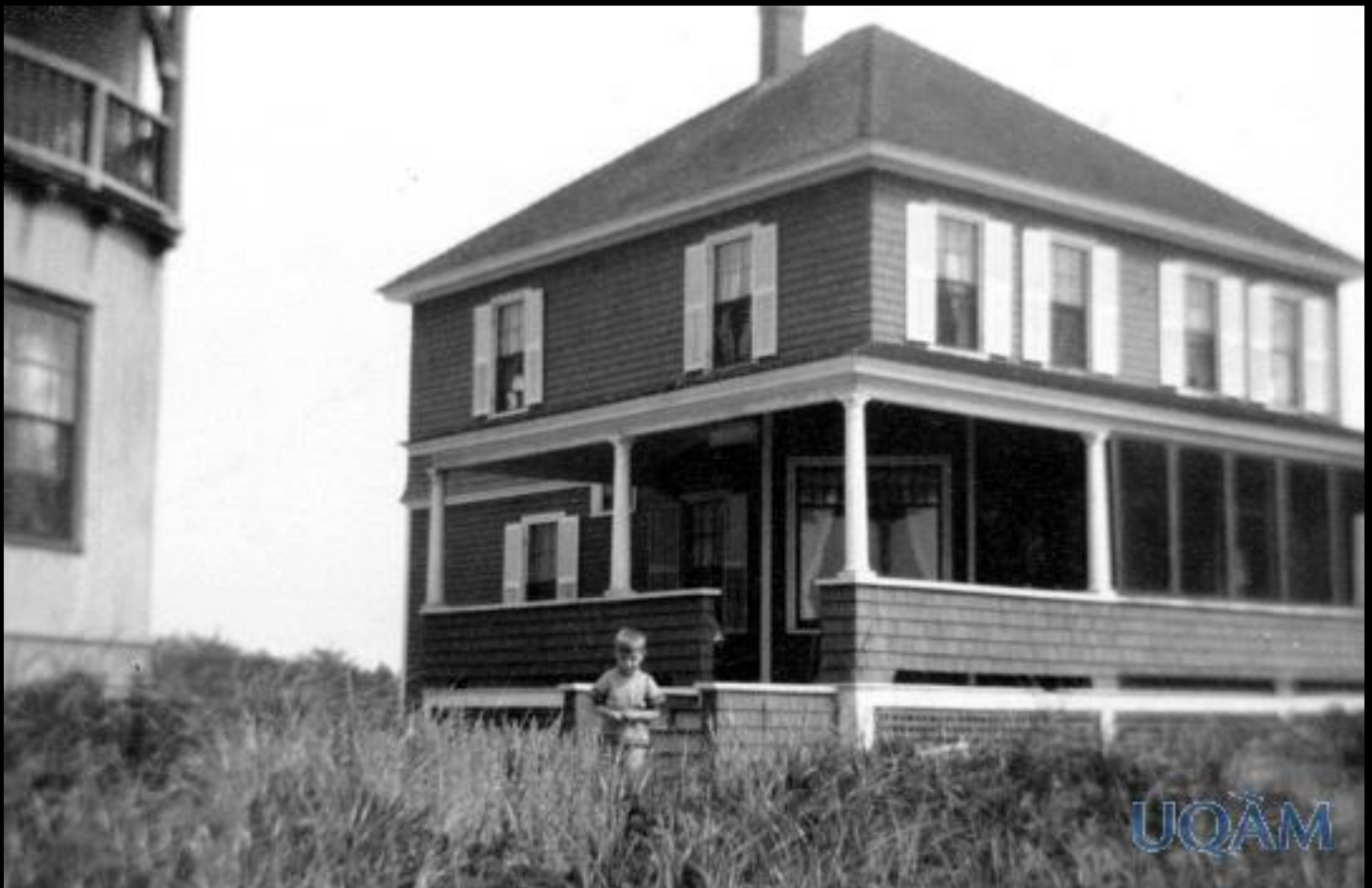
Le cottage Shea à Old Orchard - 1925
