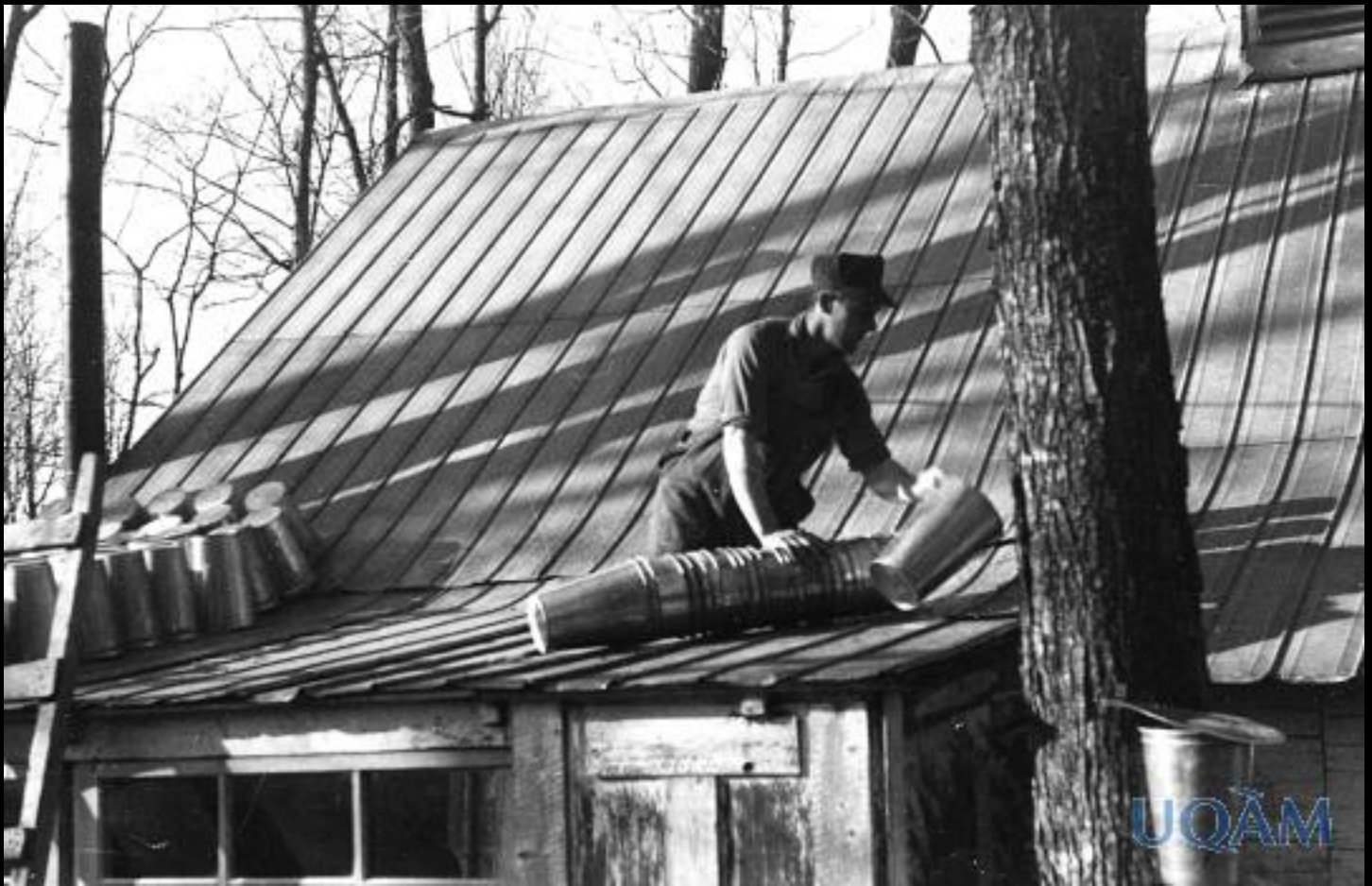
Séchage des chaudières sur le toit d'une cabane à sucre - 1944
