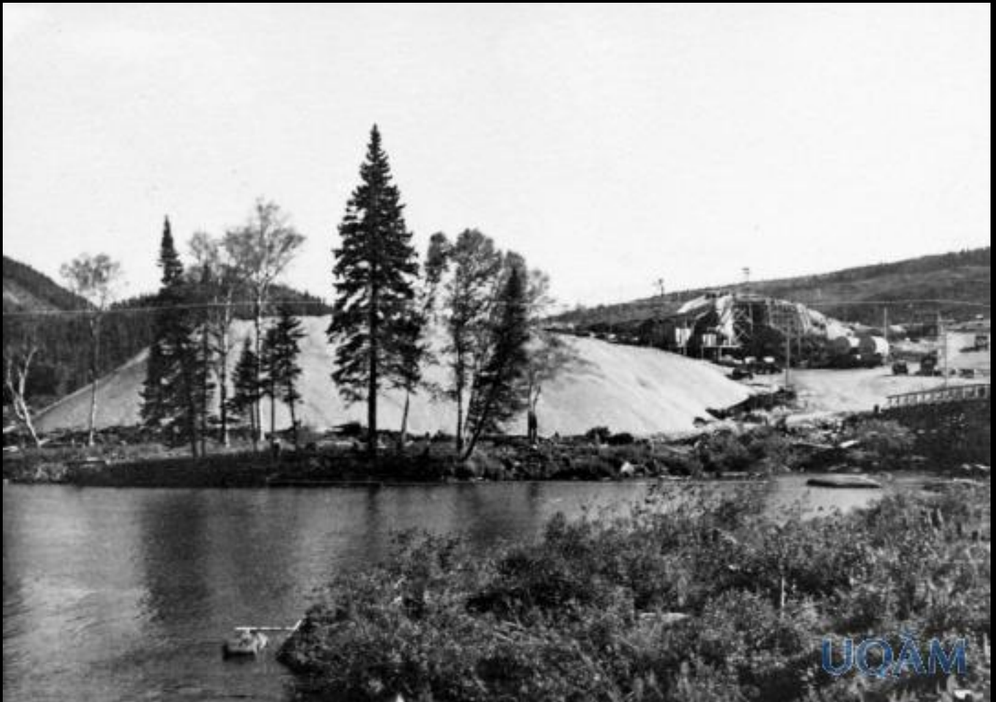
Paysage et chantier, chemin des Passes-Dangereuses au Saguenay - [195?]
