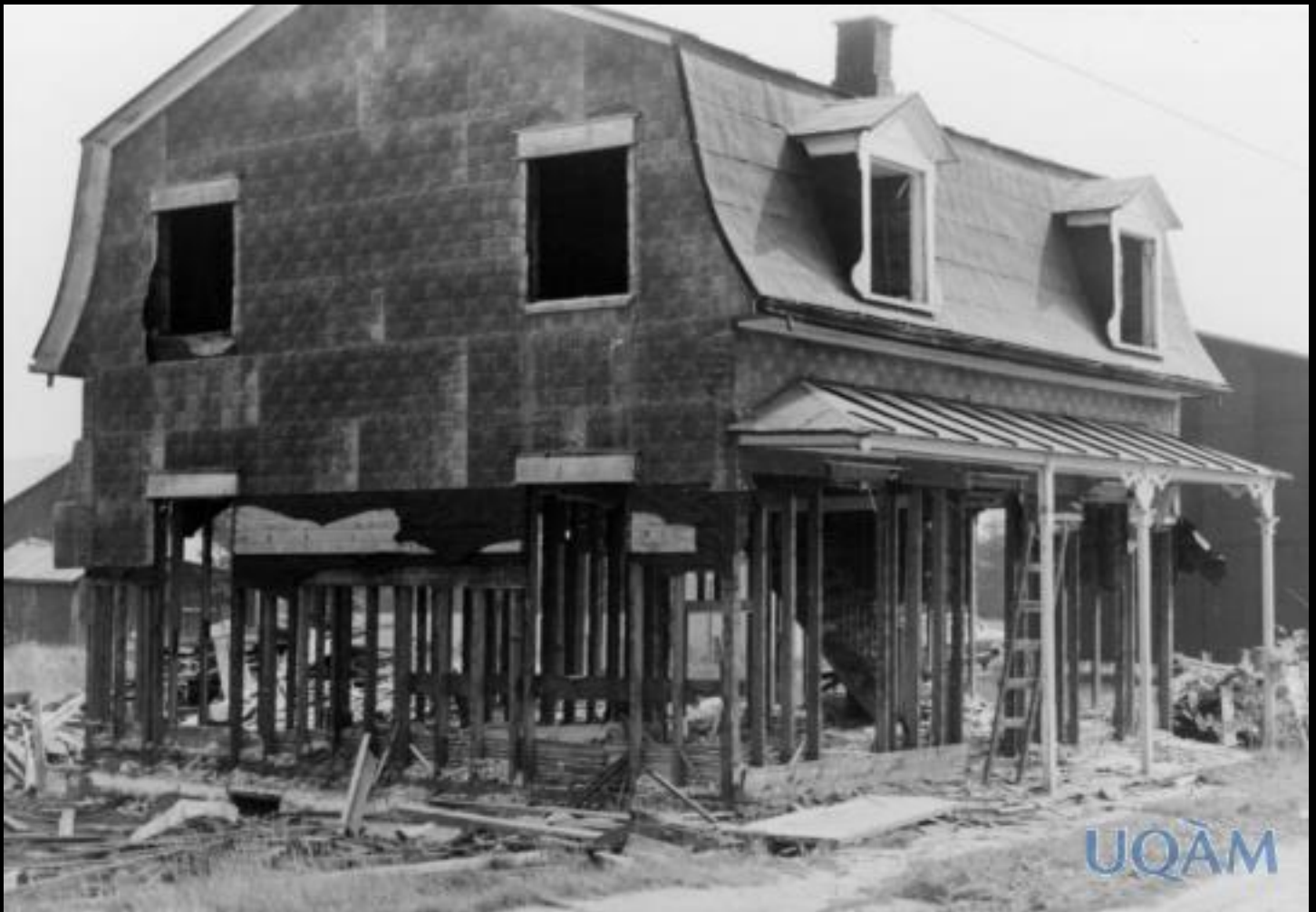
Démolition d'une vieille maison par le Bureau d'aménagement du nouvel aéroport international de Montréal (BANAIM) à Sainte-Scholastique - 1971 Caron, Jean-Paul Fonds d'archives Pierre-Dansereau Université du Québec à Montréal. Service des archives et de gestion des documents 22P-620:03:F3/6
