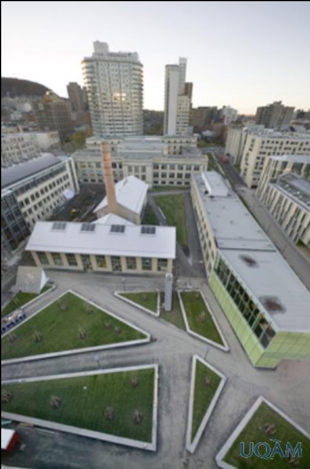
Vue aérienne du Complexe des sciences Pierre-Dansereau de l'Université du Québec à Montréal - 2005
